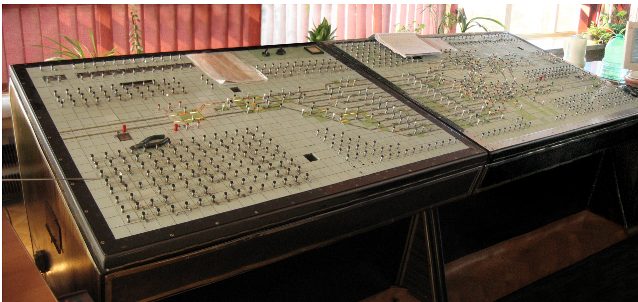
Fot. 1. Budynek stacyjny, nastawnia „KG”, pulpit nastawczy (stan z 2006 r) fot. Paweł Okrzesik
